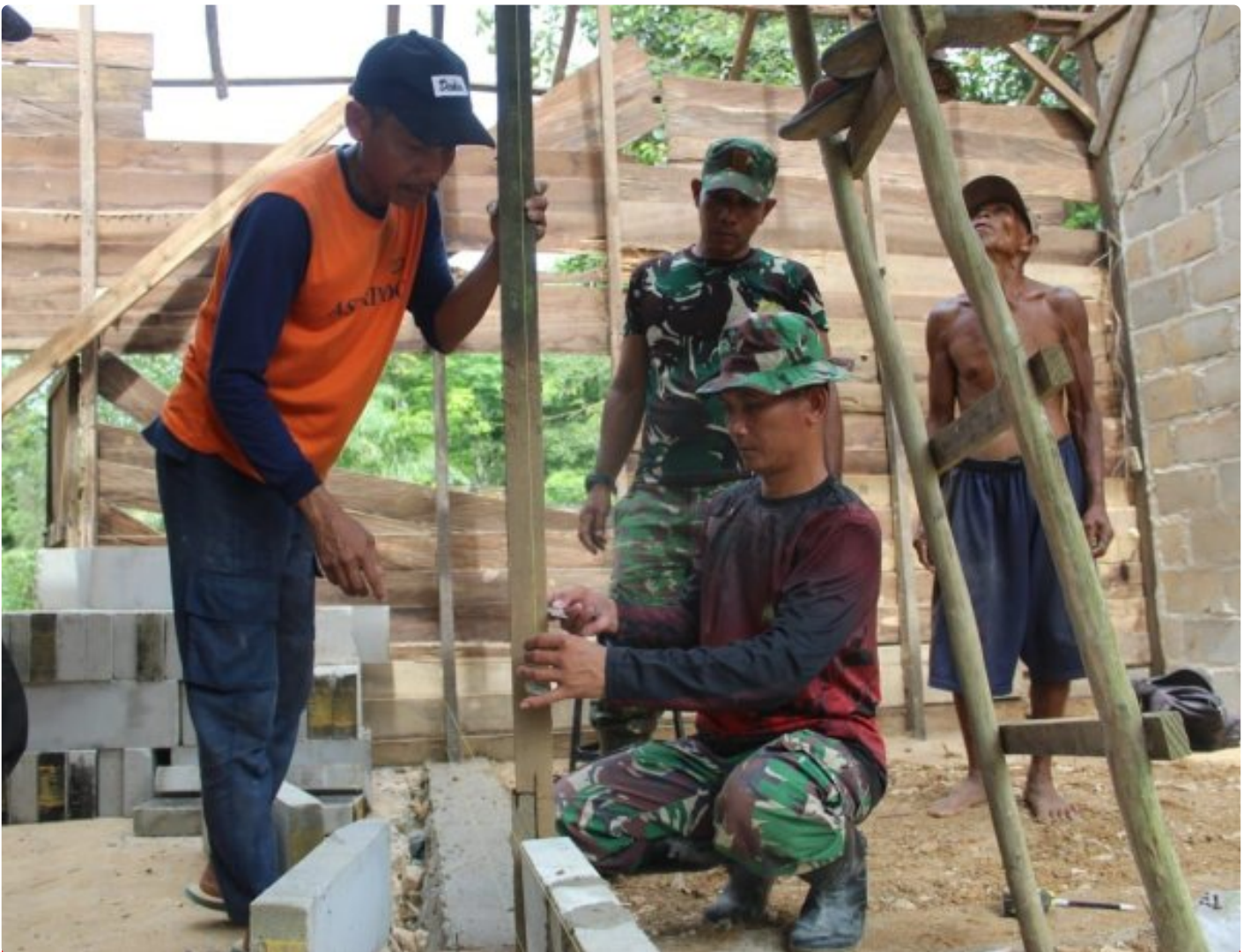
Sasaran Bedah Rumah, Sudah Tahap Pemasangan Dinding
