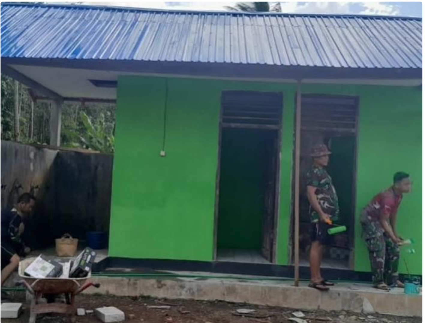
Pengerjaan Sasaran Rehab Masjid, Tinggal Finising
