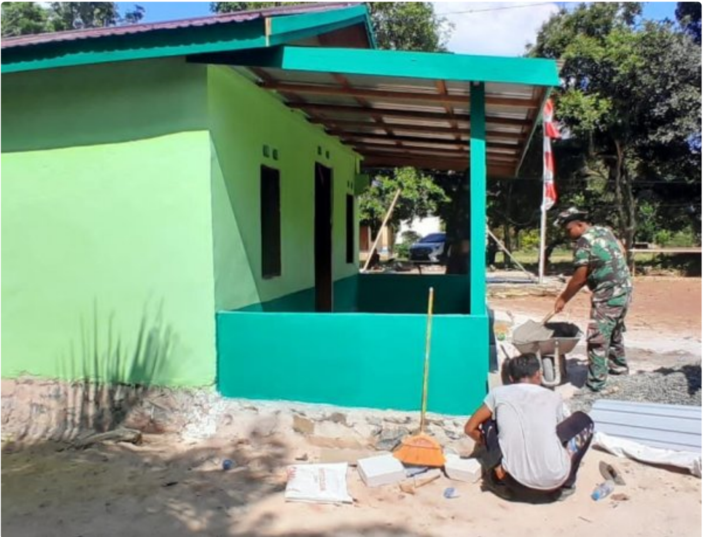
Pengerjaan Rumah Mbah Sandi Hampir Rampung
