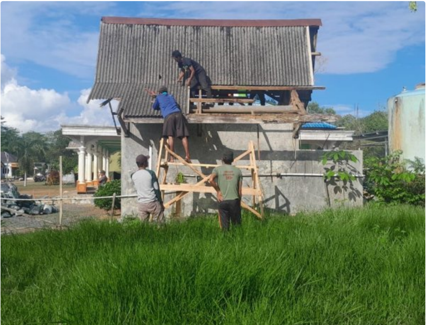
MCK Masjid Al Mujahidin Desa Telaga Langsat Dibongkar Satgas TMMD Ke 117
