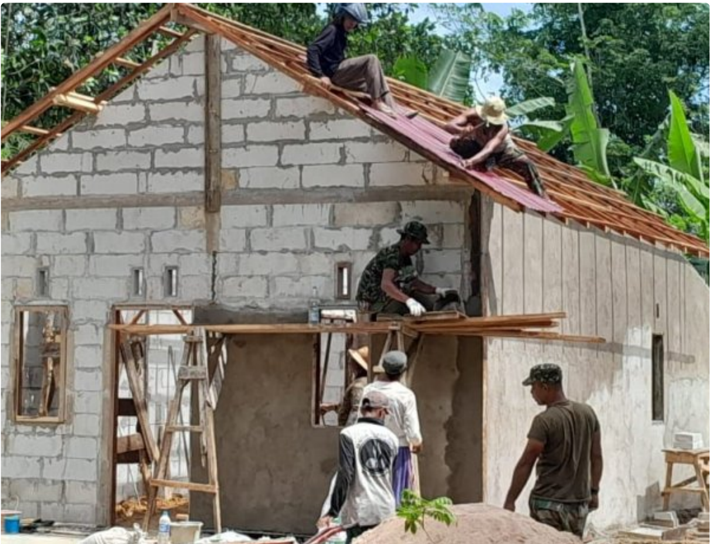
Hari Ke 15, Sasaran Rehab Rumah Sudah Terlihat Hasilnya
