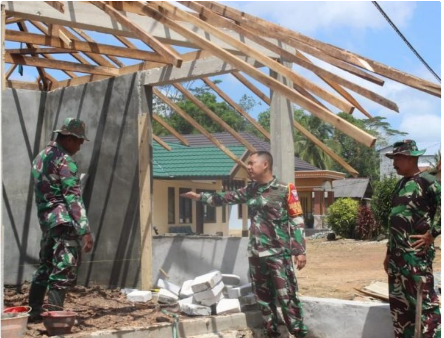
Dansatgas TMMD, Tinjau Langsung Perkembangan Dilapangan
