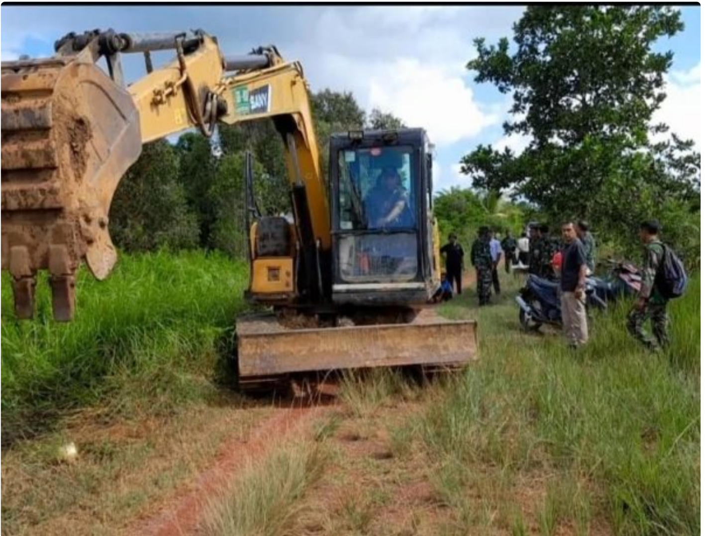
Dandim 1009/Tla, Turunkan Excavator Di Lokasi TMMD
