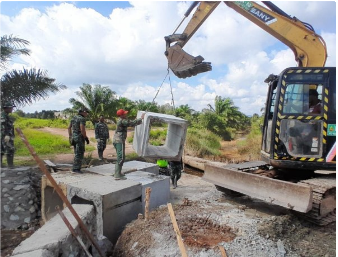
Box Culvert Jembatan Penghubung Desa Telaga Langsat Mulai Dipasang
